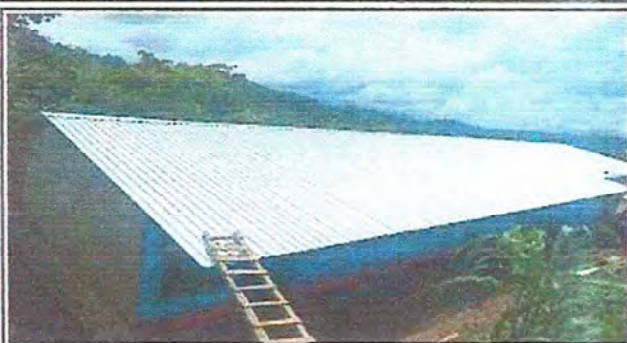
Foto1: Colocacion de laminas troqueladas de 3 aulas.
