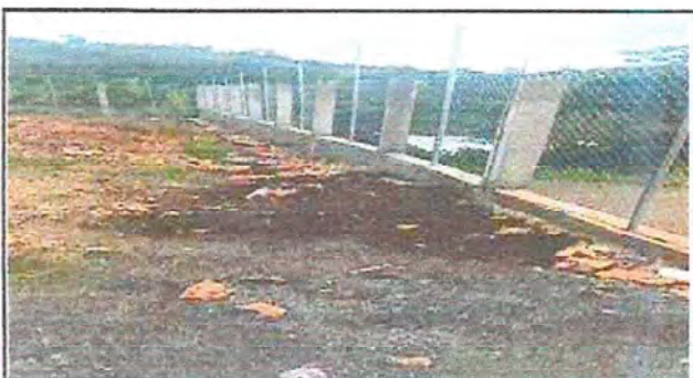
Foto 3: Circulacion de muro perimetral terminado.
