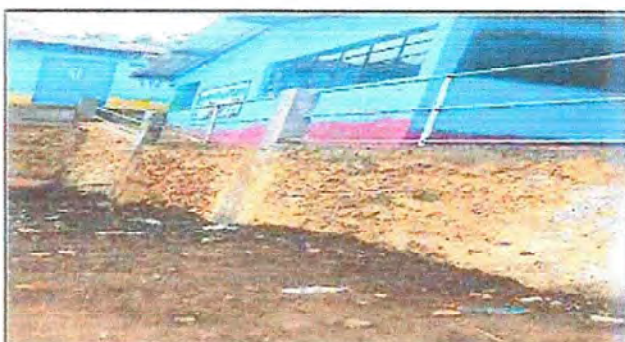
Foto 4: Circulacion de muro perimetral block.
