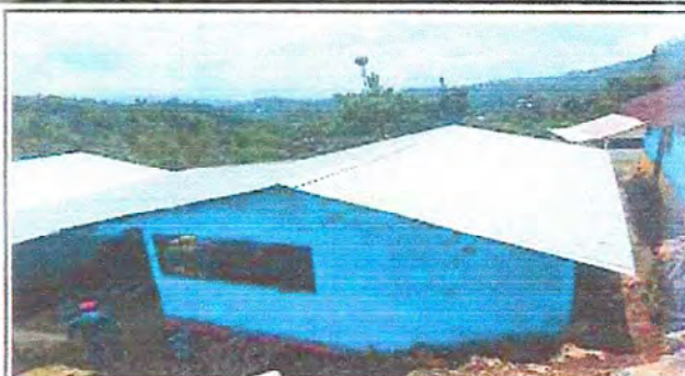
Foto 2: Instalacion de laminas troqueladas.
